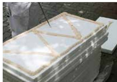
Incollaggio di pannelli isolanti in sistemi a cappotto ETICS/EIFS
