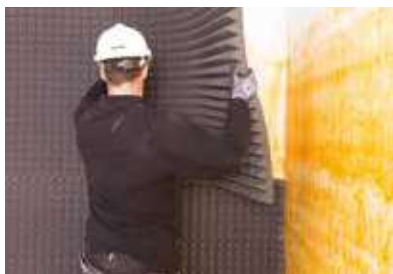
Incollaggio di isolamento su superfici lisce
